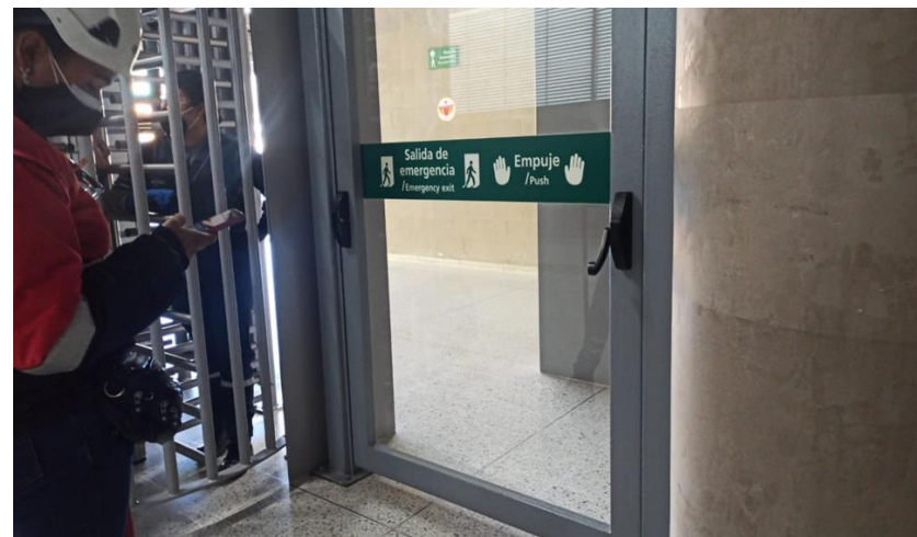
Revisión puertas de emergencias
