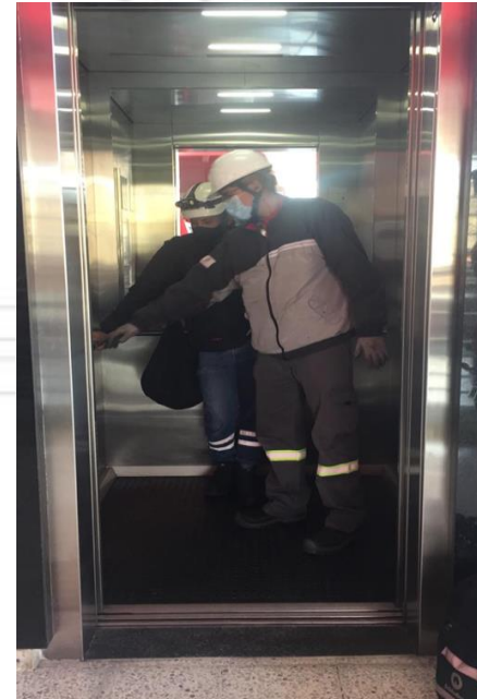
Verificación de ascensores
